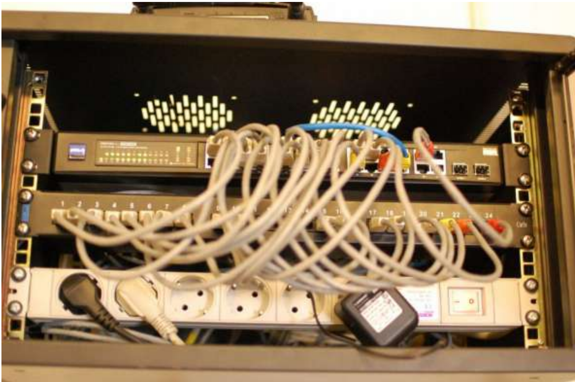
18. ábra. Kommunikációs elosztó, IDF
