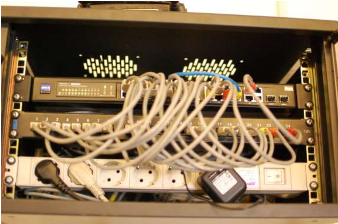
11. ábra. Aktív eszköz (switch) kommunikációs szekrényben
