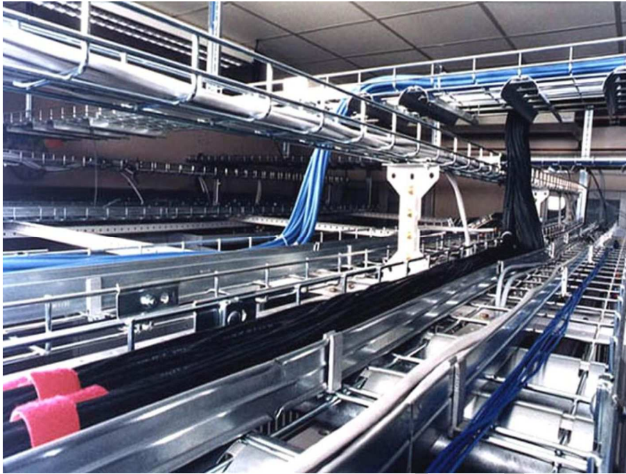
19. ábra. Tálcákon vezetett kábelek és keresztezésük
