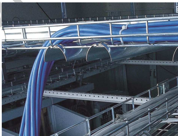
22. ábra. Kábeltartó ívek alkalmazása
